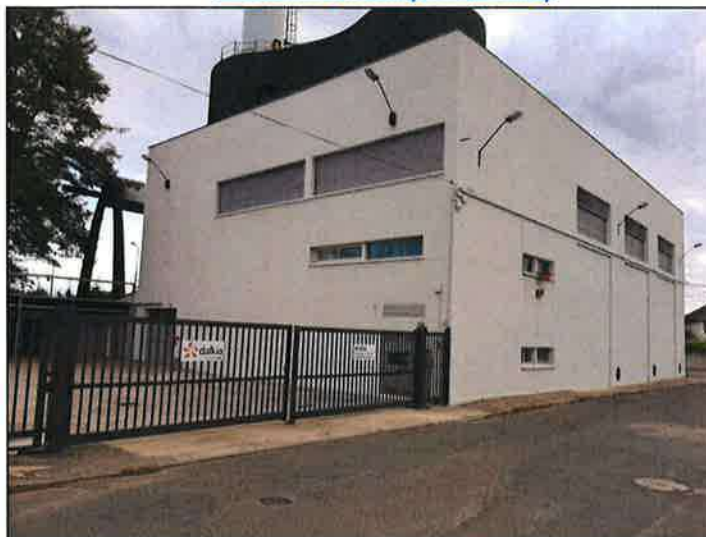
Figure 4 : Photo de la chaufferie du Banlay
